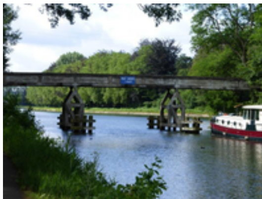
Afbeelding 9: Betonnen jaagbruggen (Bron: Kennes, Hilde, 31-07-2013, ©Vlaamse Gemeenschap )
